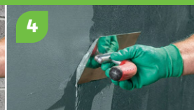
4 Nałożenie drugiej warstwy hydroizolacji BotaGreen® RD 2morrow
