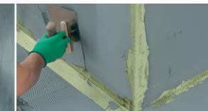
6 Obróbka detali: Wklejenie taśmy uszczelniającej BotaGreen® (doszczelnienie połączenia ściana / fundament)
